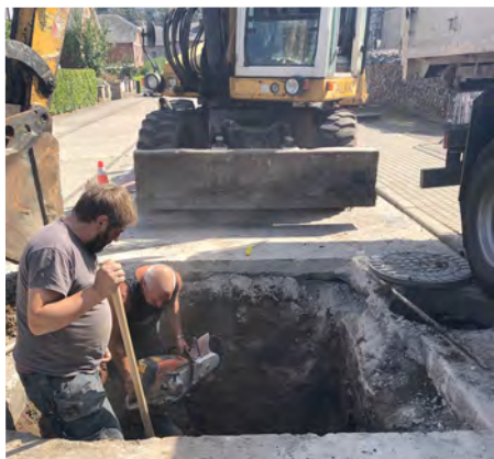
Réparation de l'égouttage
