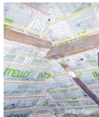
Isolation toiture avec cellulose (400 m²)
