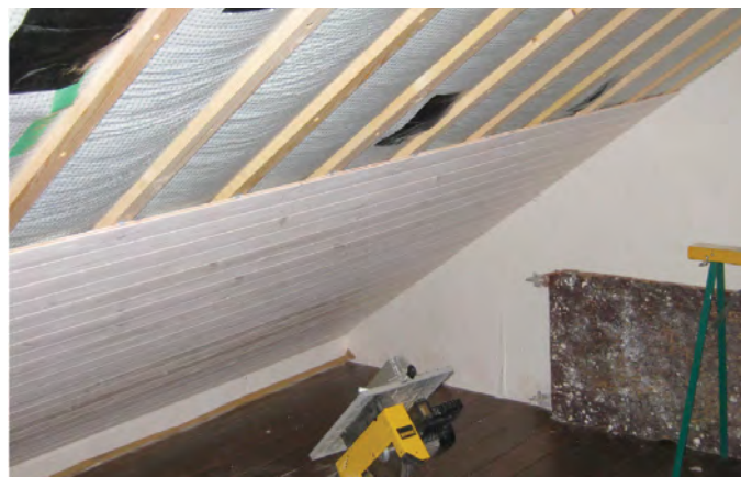
Isolation toiture avec cellulose (100 m² avec finition)
