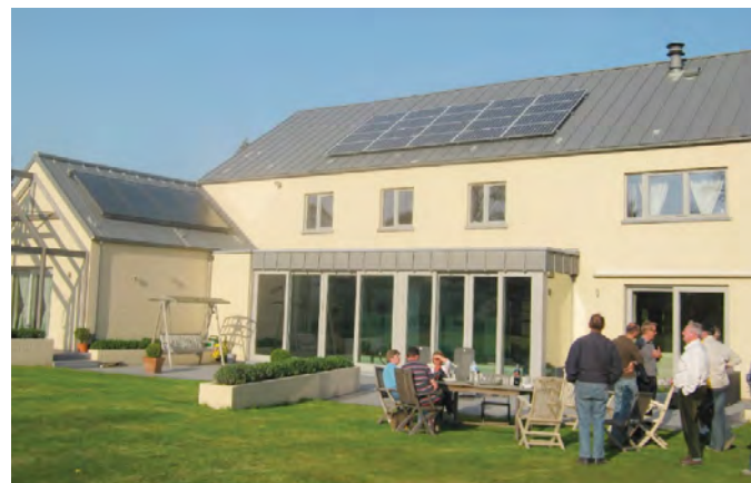
Solaire thermique et photovoltaïque – Corroy-le-Château
