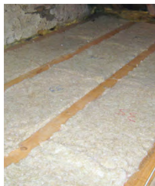
Isolation plancher de grenier avec laine de chanvre
