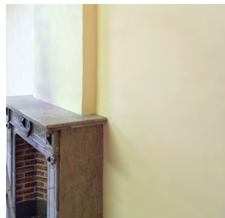
Travaux de peinture au presbytère de Bioul
