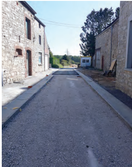
Travaux voiries rue Gotale
