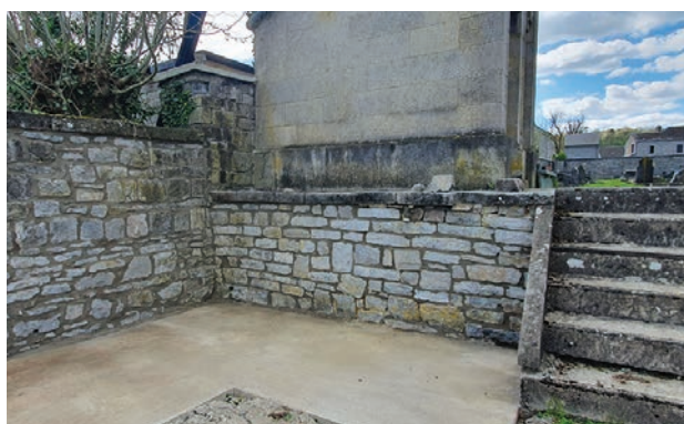
Travaux restauration cimetière de Warnant
