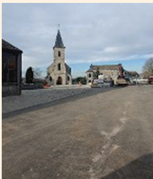
Travaux, place des français à Haut-le-Wastia
