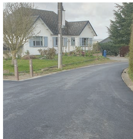
Travaux asphaltage Bioul
